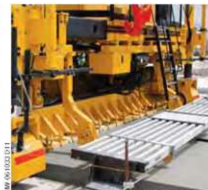
Бетоноукладчик GOMACO GP-2400 со скользящей формой серии 3100 и регулируемой стальной пластиной для окончательной отделки поверхности покрытия.
