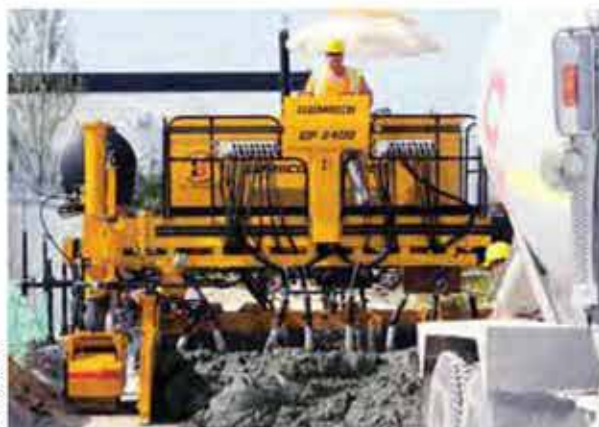
Программное обеспечение G+ и система управления GP2400 для работы по копирной технологии (по струне).
