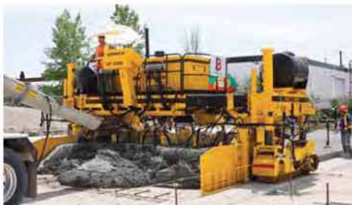
Платформа оператора обеспечивает хороший обзор процесса укладки.
