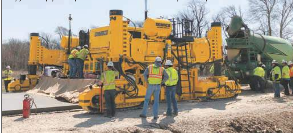
Бетоноукладчик GOMACO GP4 в четырёхгусеничном исполнении с системой нивелирования 3D укладывает в скользящей опалубке покрытие шириной 7,92 м (26 футов). Машина оборудована формой серии 5400 и системой вставки стержней в продольные швы.
