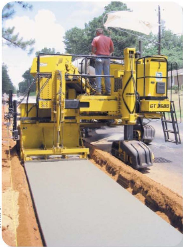
Минимальный зазор и высокая производительность достигнуты с использованием GT-3600, бетонирующим этот тротуар шириной 1,52 м в Алабаме.
