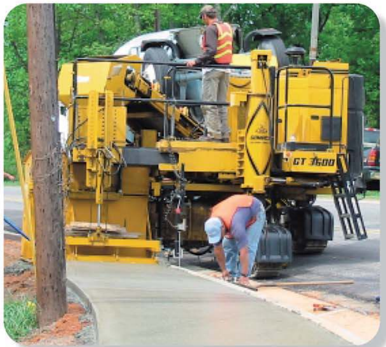
Минимальный зазор на GT-3600 обеспечивает возможность избегать препятствия, такие как телефонные и фонарные столбы. В качестве исходной точки для рулевого управления и угла наклона взят существующий бордюр в данном проекте бетонирования тротуара.
