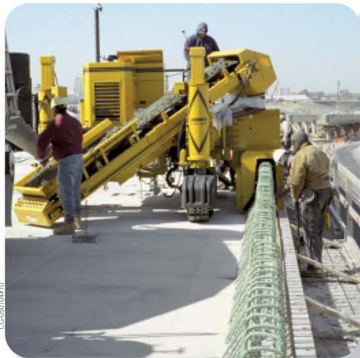
В данном проекте GT-3600 бетонирует парапет моста высотой 813 мм с использованием армированного каркаса.
