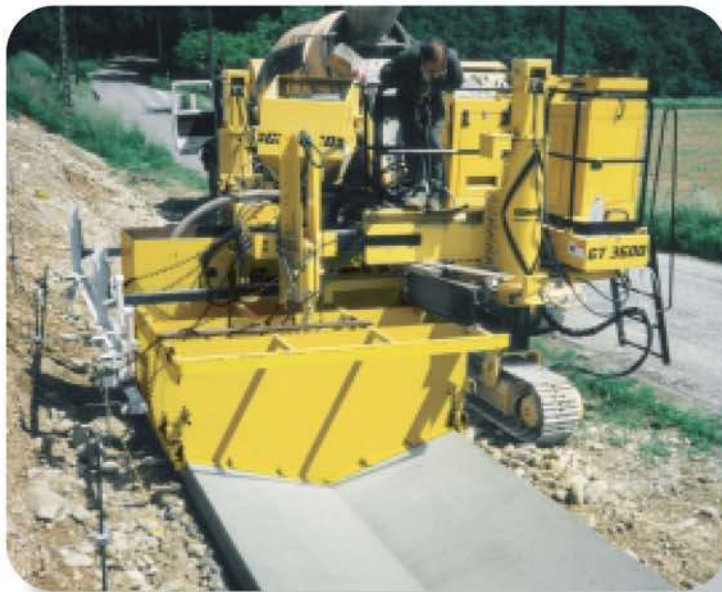
Универсальный GOMACO GT-3600 бетонирует дренажный канал во Франции. Боковое расположение конструкции обеспечивает минимальный зазор с левой стороны от формы.
