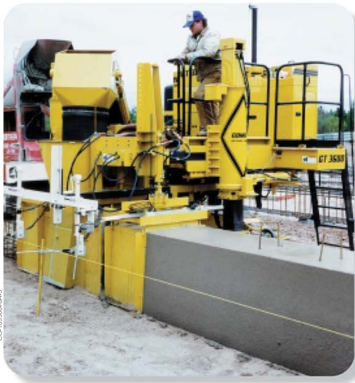
Другая уникальная операция бетонирования выполнена с использованием GT-3600 - это фундамент катка для фигурного катания.
