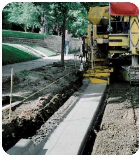
Этот бетоноукладчик GT-3600 имеет гильотинный депрессор.
