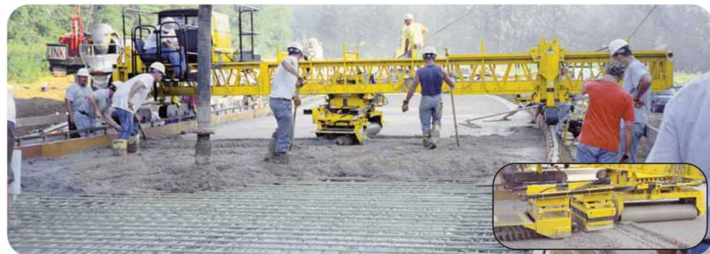
Финишер С-450 с высокой производительностью укадывает покрытие на этом мостовом настиле в Индиане. Подрядчик оборудовал свою модель С-450 двойным цилиндром, регулируемым поверхностным поддонным вибратором и регулируемыми фрезами, что позволяет быстро, легко и точно регулировать уклон.
