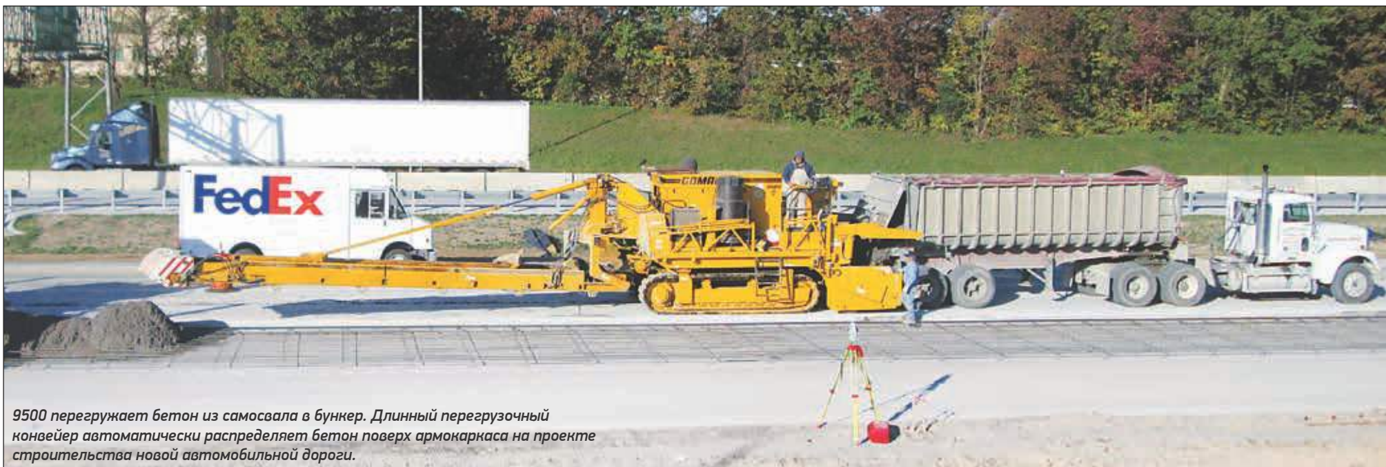
Система захватывает и блокирует задние колёса автосамосвала и толкает его, пока загружается бункер.
