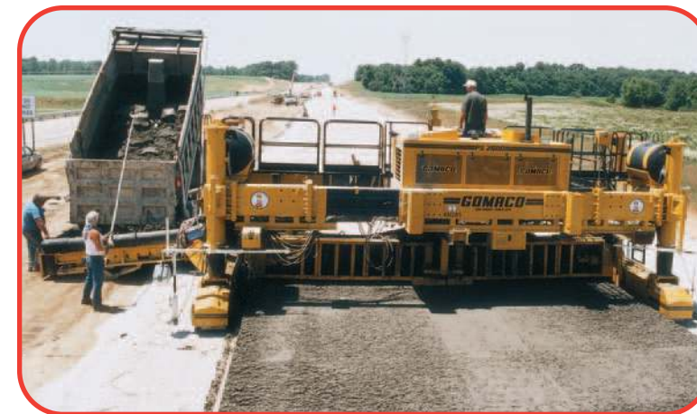
Бетонораспределитель PS-2600 оснащен профилирующим рабочим органом шириной 7,32 м, который включает в себя центральную регулируемую вставку. Дополнительные секции позволяют увеличить ширину полосы распределяемой бетонной смеси.
