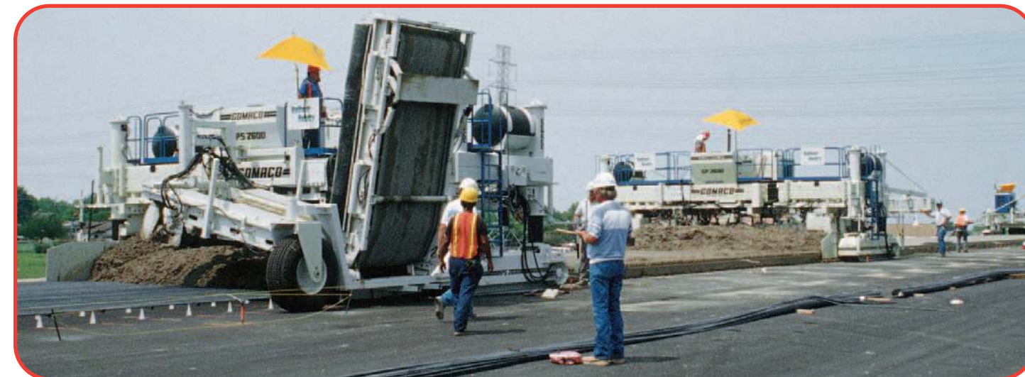
Комплект бетоноукладочных машин корпорации GOMACO, состоящий из бетонораспределителя PS-2600, бетоноукладчика со скользящими формами GP-2600 и машины T/C-600 для образования шероховатости на поверхности покрытия и распределения пленкообразующих материалов, обеспечивает высокую производительность работ и прекрасное качество поверхности укладываемого покрытия.
