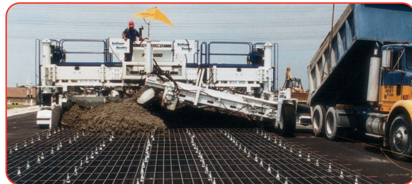
Бетонораспределитель PS-2600 использовался для распределения бетонной смеси на основание при устройстве армированного дорожного покрытия.
