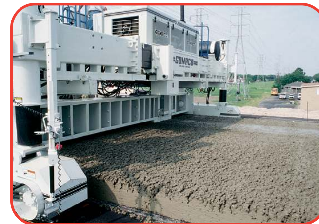
Бетонораспределитель PS-2600 оснащен профилирующим рабочим органом шириной 7,32 м, который включает в себя центральную регулируемую вставку. Дополнительные секции позволяют увеличить ширину полосы распределяемой бетонной смеси.
