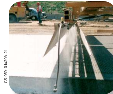
Навесной распылитель для распределения пленкообразующего материала
