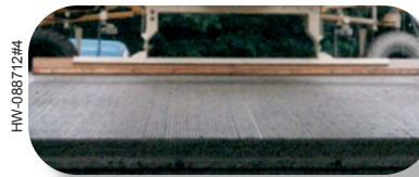
Щетка для образования шероховатости на поверхности свежеуложенного покрытия
