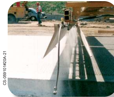
Навесной распылитель для распределения пленкообразующего материала
